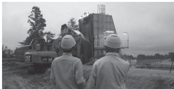
写真2 山田町CMJVの復興現場の様子
